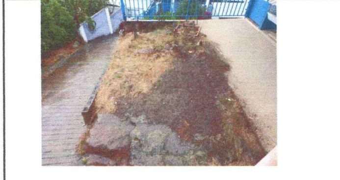
Foto 2: sustitución de torta de concreto
