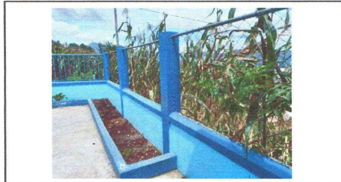
Foto 4: Sustitución de baranda de metal
