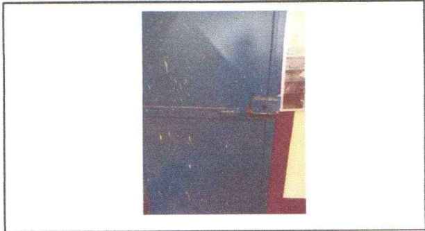
Foto7: Sustitución de chapa
