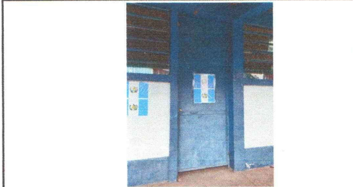
Foto 1: Mantenimiento a estructura y sustitución de chapa a puerta de metal
